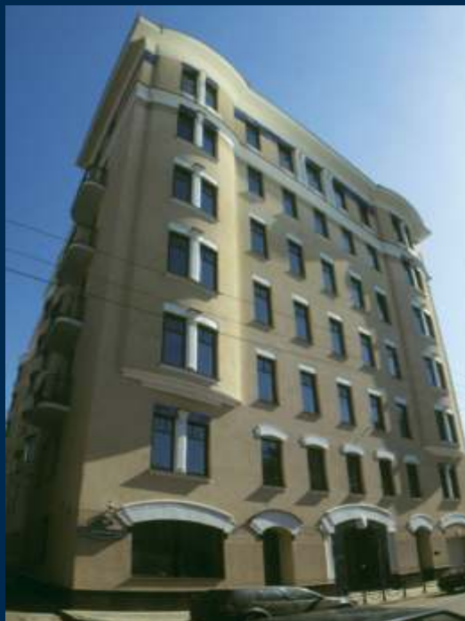
Жилой дом в Трубниковском переулке
